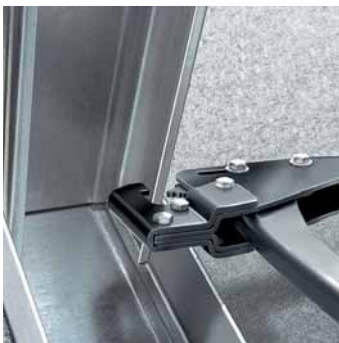
Установка инструмента на оба соединяемых профиля
